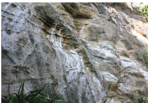
No. 35 大神島北東内陸部の風潮塩壁面露頭
