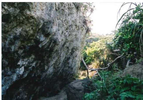
急斜面の欠壊・崩落の防止保護となる (2014.3)
